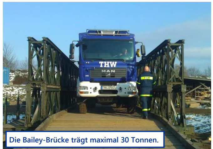
Bau einer Bailey-Rampe, damit ein schweres Bohrfahrzeug sein Einsatzgebiet erreichen kann.
