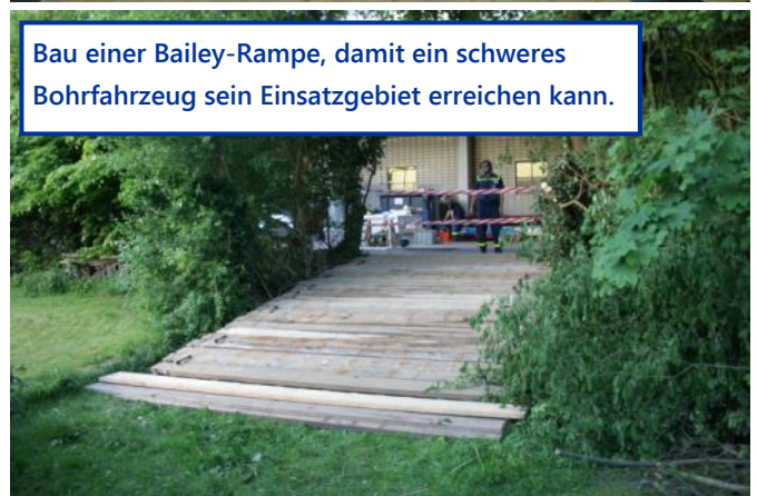
Die Bailey-Brücke trägt maximal 30 Tonnen.
